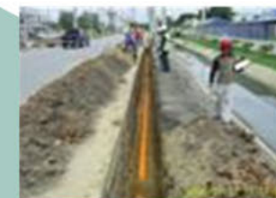
การวางท่อแบบขุดเปิด
