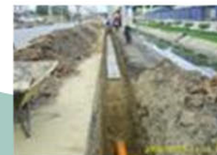
การวางท่อแบบขุดเปิด
